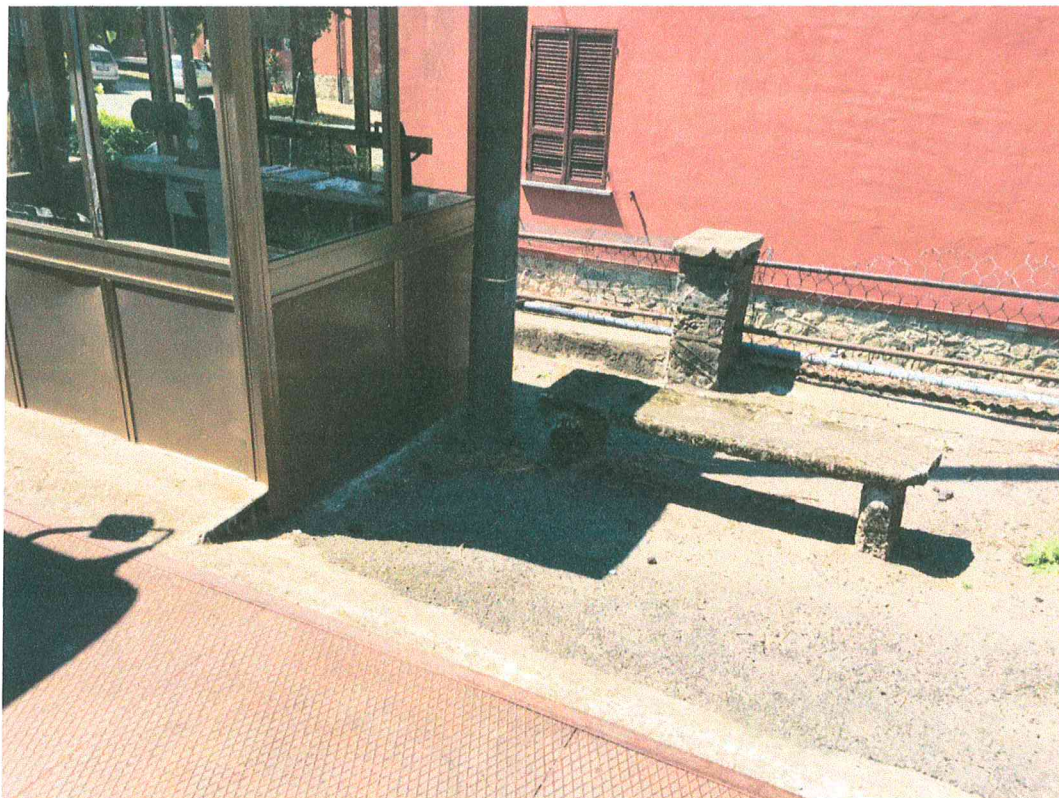
FOTO 7 Particolare casetta in metallo da sostituire con casetta in legno
