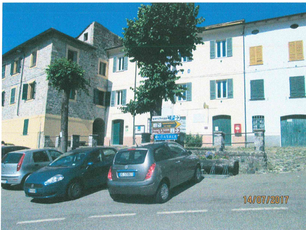
FOTO 2 Prospetto fronte Palazzo Comunale
