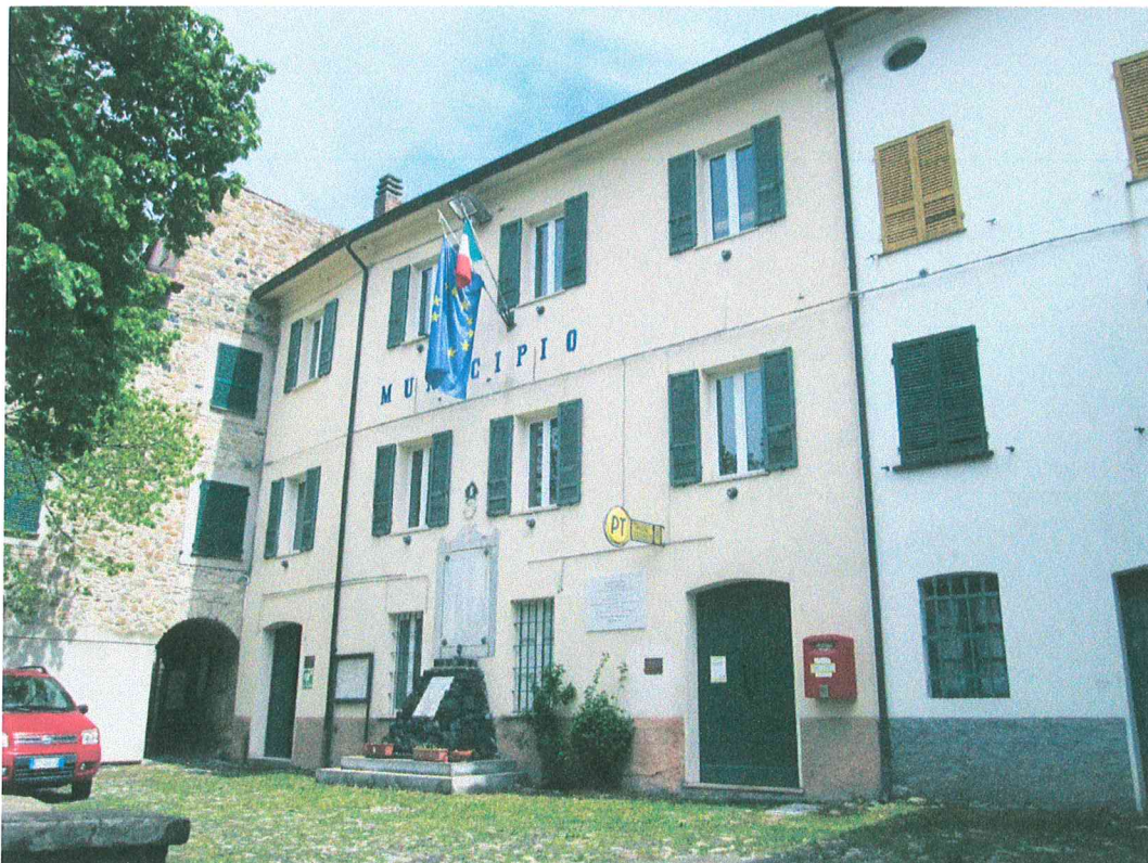
FOTO 1 Prospetto fronte Palazzo Comunale
