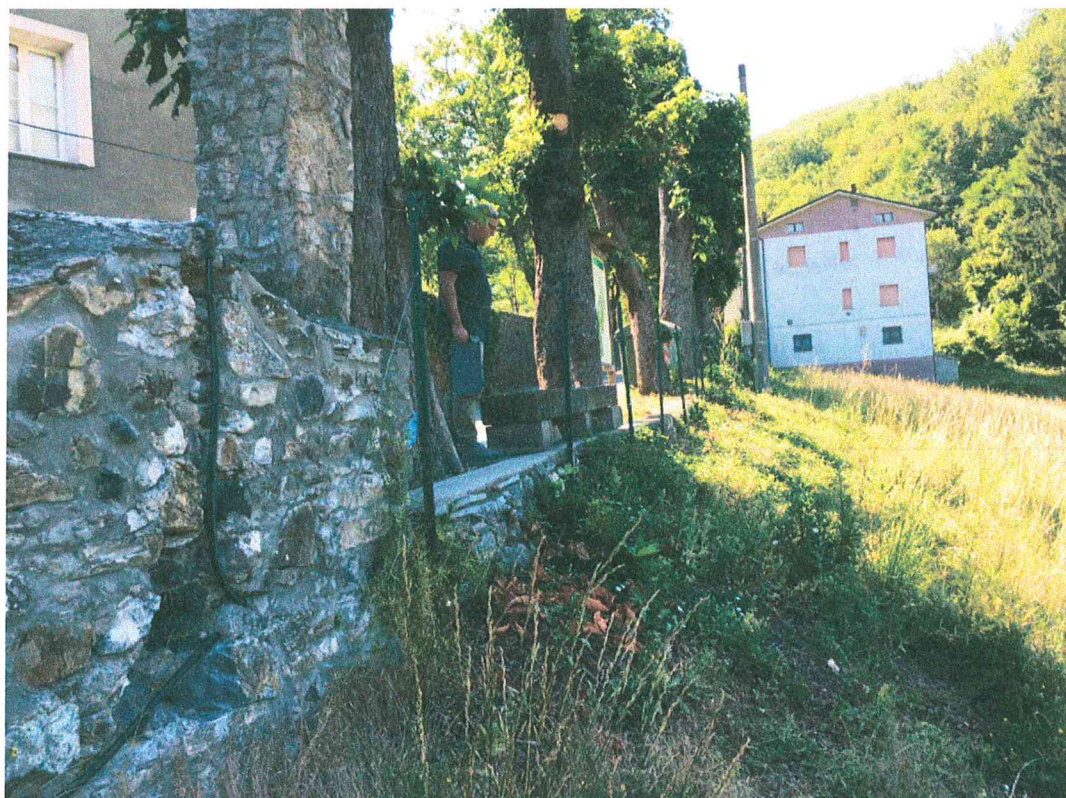
FOTO 10 Particolare muro Ponte Organasco
