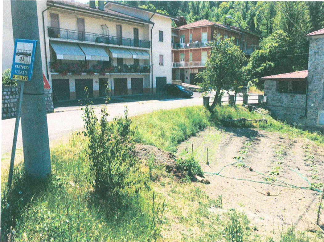
FOTO 5 Particolare argine Strada Provinciale dove verrà realizzato il muro di contenimento
