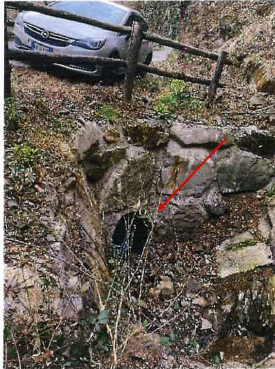
Figura 17 - Scarico al di sotto della strada da ripulire
