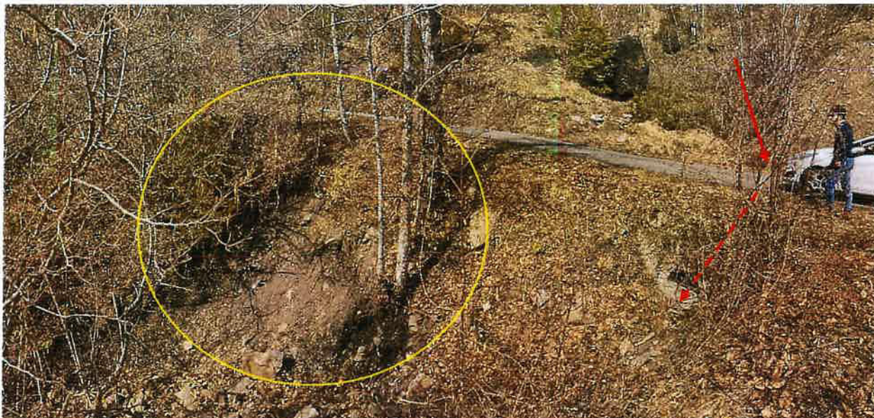
Figura 33 - Dettaglio della tubazione e della zona di scarico a valle della strada
