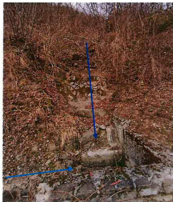
Figura 5 - Scarico (a) e Tombino (b) da ripulire
