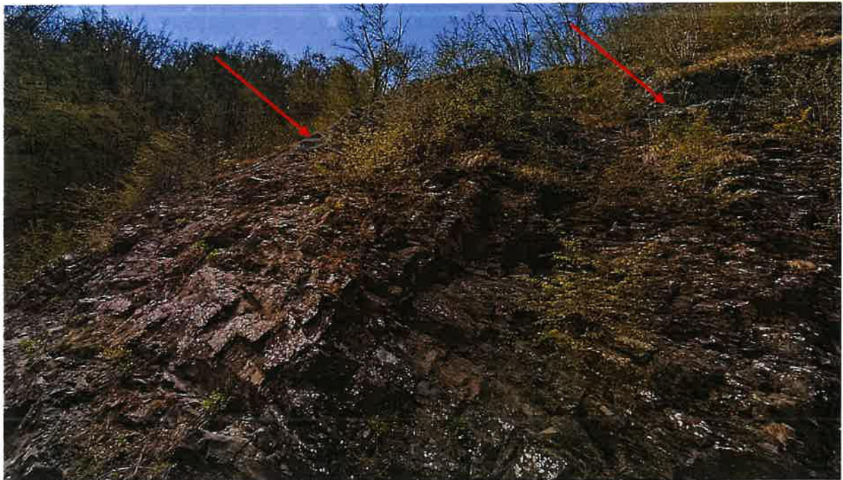
Figura 18 - Panoramica dell'area di intervento (verso valle). Le frecce indicano le porzioni di rete paramassi già presenti sulla parete
