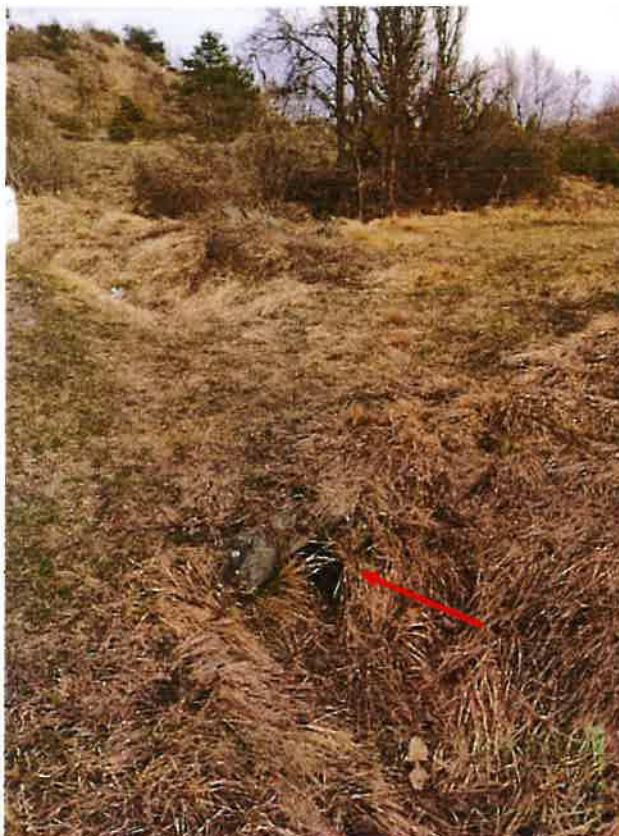
Figura 13 - Scarico da ripulire
