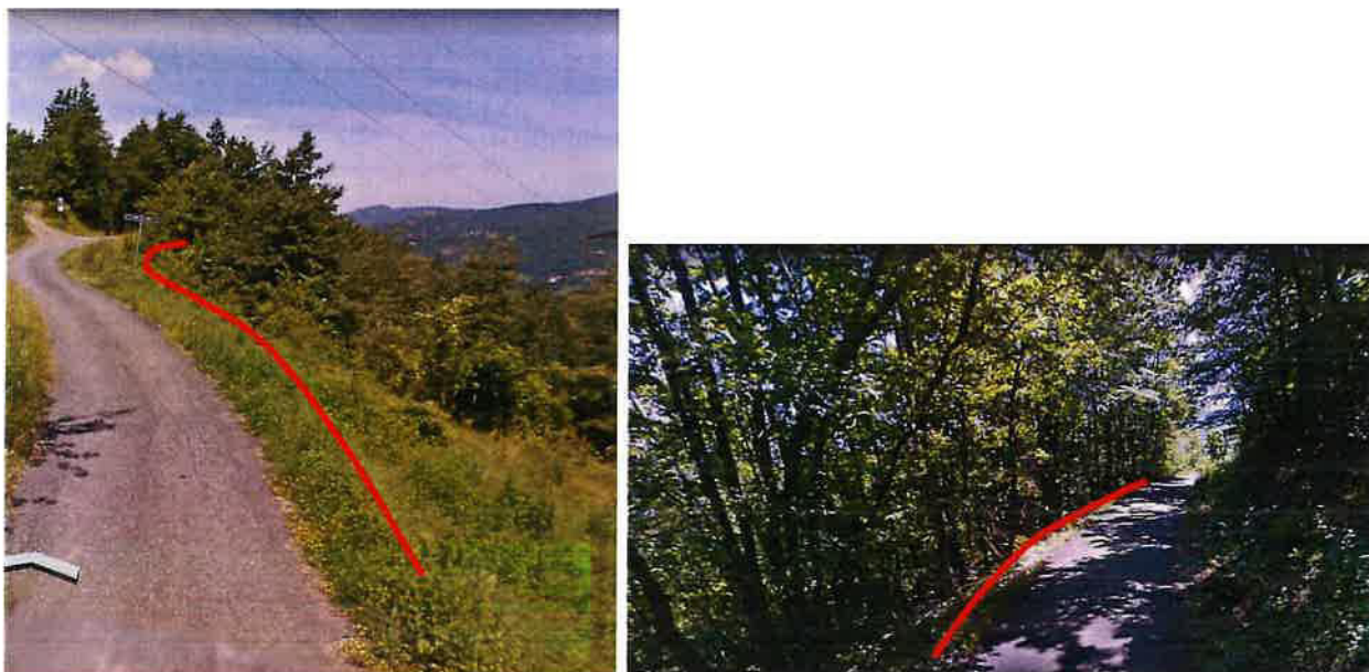
Figura 9-10 - Tratto di strada ove è in progetto la posa di un guard-rail. L'acclività elevata del lato di valle è molto evidente
