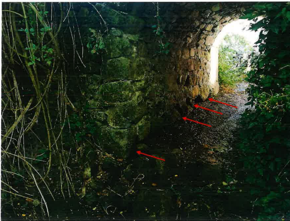
Figura 7 - Condizioni del ponte e alcuni punti di intervento
