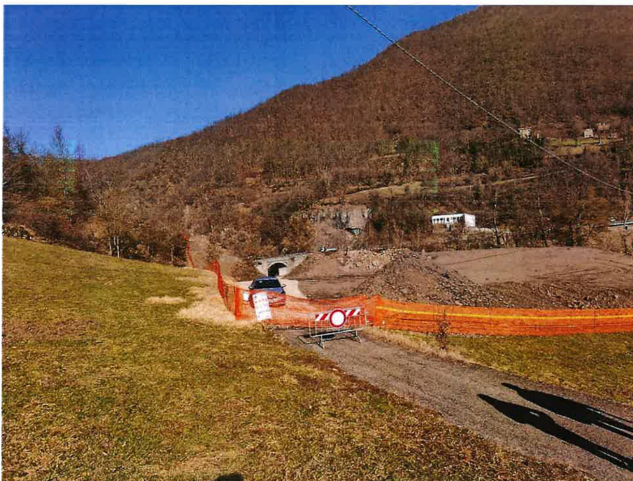
Figura 2 – Tratto precedentemente interessato dal cantiere e punto di inizio del settore oggetto di intervento
