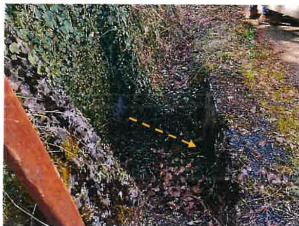
Figura 11-12 - Tombino e scarico da ripulire
