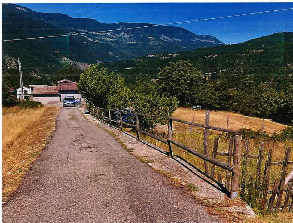
Figura 3 - Tratto A della staccionata da sostituire
