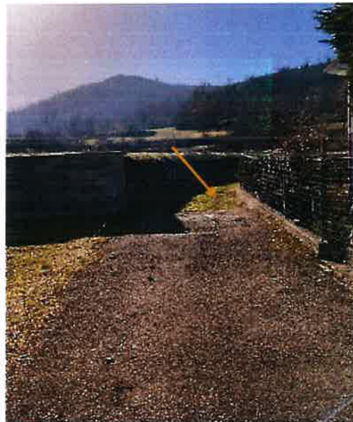
Figura 2-3 - Tombino da ripulire presente alla fine del tratto di strada asfaltata
