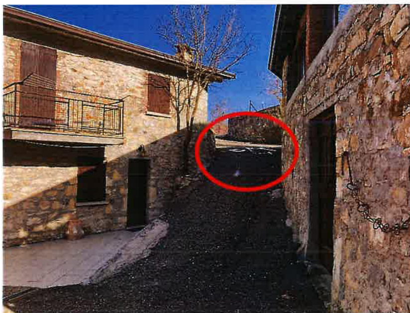
Figura 7 - Riprofilatura della strada
