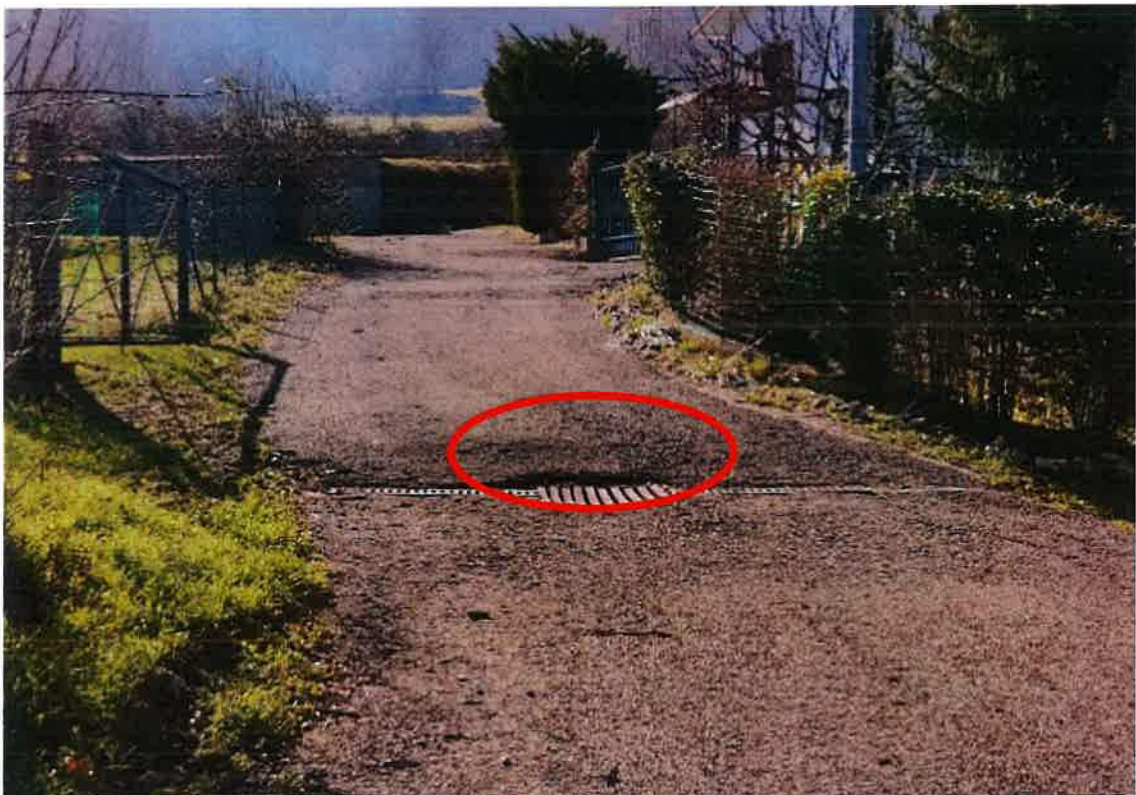
Figura 5 - Rimozione del dosso (cerchio rosso) mediante riprofilatura della sede stradale
