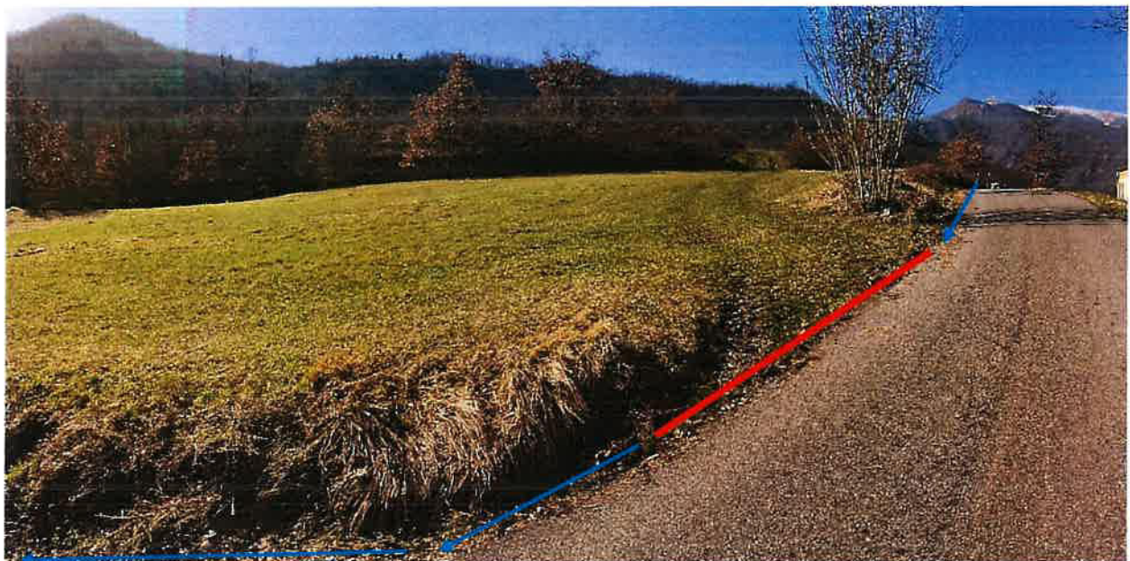
Figura 15 - Passacunetta in progetto e cunetta da ripristinare
