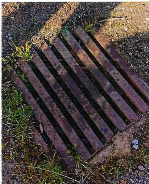
Figura 2-3 - Tombino da ripulire presente alla fine del tratto di strada asfaltata
