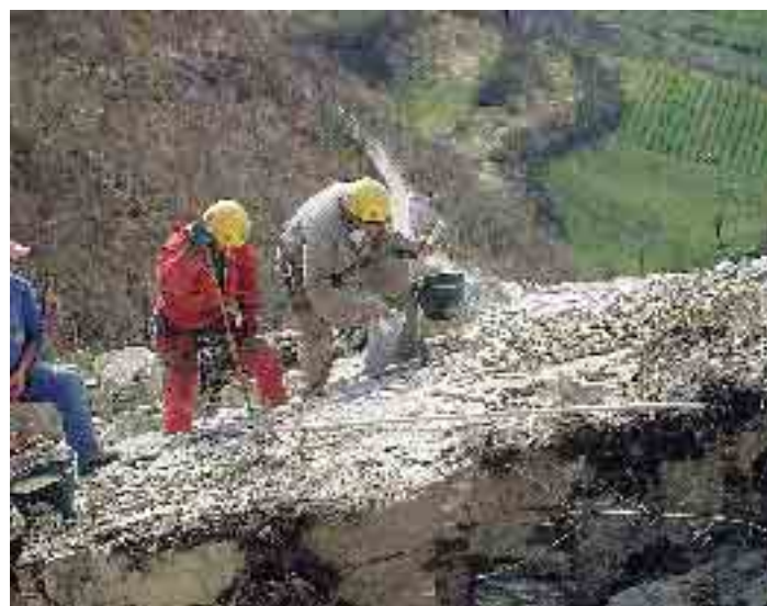
Ieri sono state fatte in totale cinque "volate" (cioè esplosioni): in una è stato fatto brillare un masso da 1.250 metri cubi di terreno, l'altra ha messo ko un masso da 350 metri cubi; poi si è intervenuti anche nella gola del "valico"
